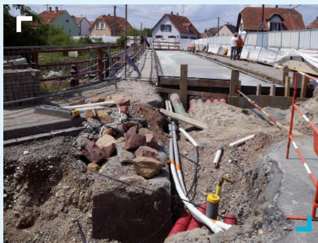
Les travaux sur le pont de la Bruche touchent à leur fin. Pour construire la passerelle, qui sera accrochée à l'ouvrage cet automne, il a été nécessaire de renforcer le pont existant qui n'avait pas été réalisé en béton armé. Ainsi, une dalle de béton armé a été créée, dans laquelle la passerelle sera ancrée.
