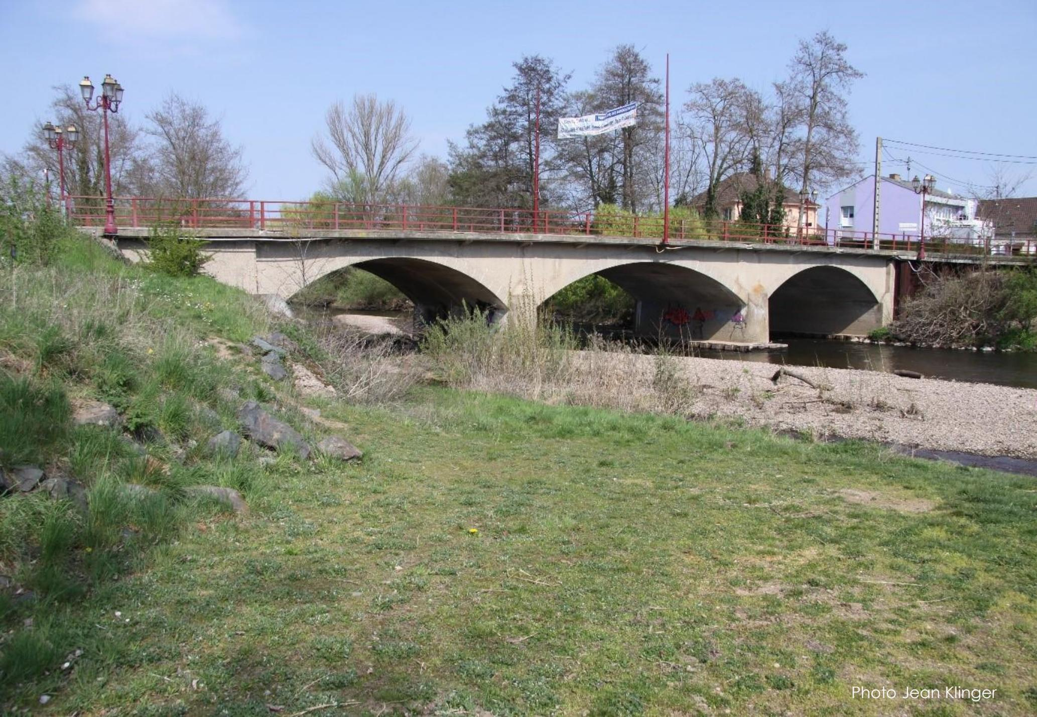
La plupart des ponts dynamités furent reconstruit vers 1953. Celui de Holtzheim sera en béton afin de résister aux crues de la Bruche
