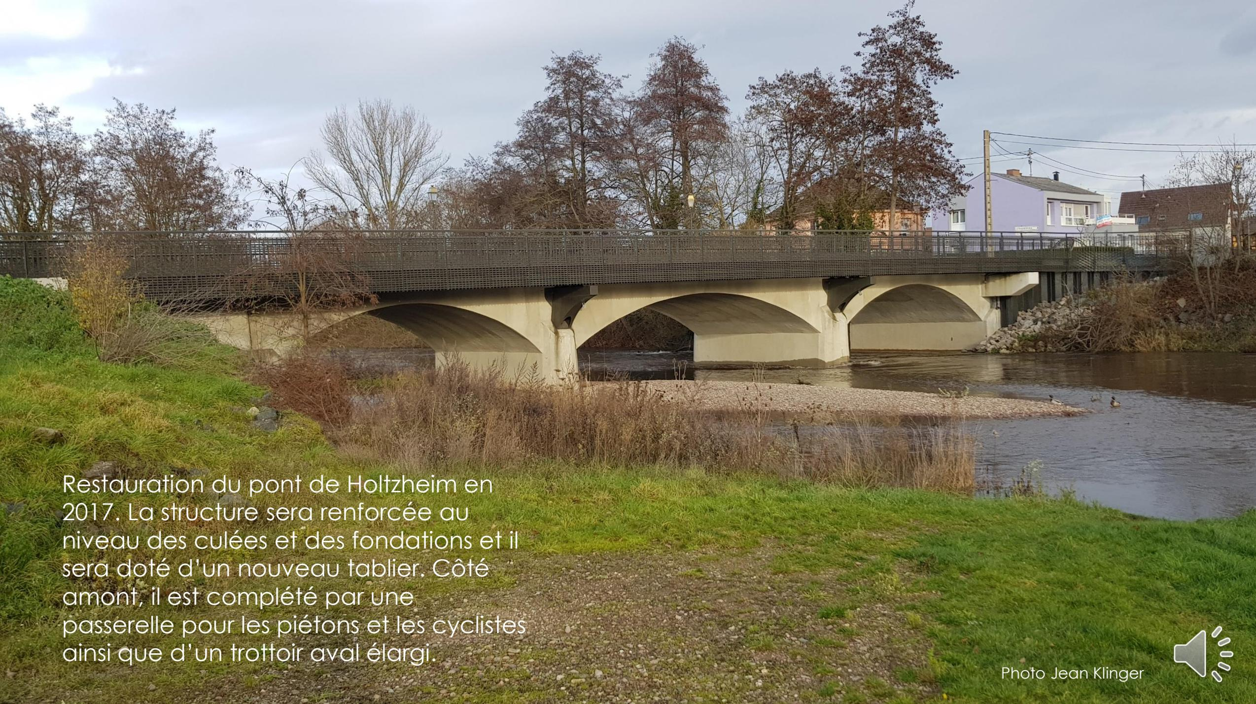
Restauration du pont de Holtzheim en 2017. La structure sera renforcée au niveau des culées et des fondations et il sera doté d'un nouveau tablier. Côté amont, il est complété par une passerelle pour les piétons et les cyclistes ainsi que d'un trottoir aval élargi.
